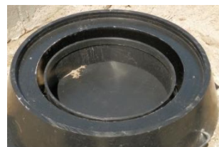
Zdj. nr 13 Założenie stożka na część cylindryczną
