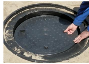
Zdj. nr 15 Założenie pokrywy PE
