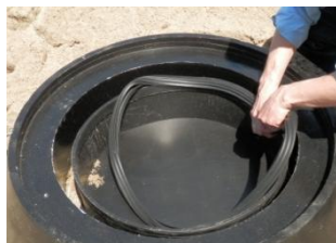
Zdj. nr 14 Założenie uszczelki
