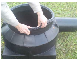
Zdj. nr 24. Montaż uszczelki DN 614
