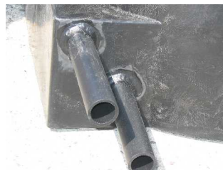
Zdjęcie nr 17. Dwie rury polietylenowe wspawane do korpusu zasobnika
