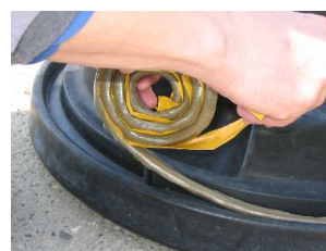
Zdjęcie nr 29. Nakładanie uszczelki UP
