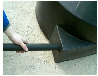
Zdjęcie nr 7. Zakładanie rury PE w gniazdo z uszczelką
