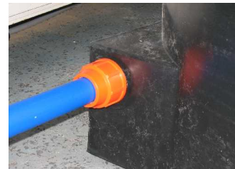
Zdjęcie nr 10. Rura połączona z korpusem za pomocą złączki skręcanej
