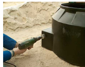
Zdjęcie nr 4. Wycinanie otworu wyrzynarką
