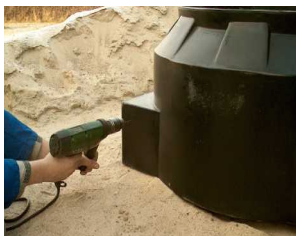
Zdjęcie nr 3. Wiercenie otworu prowadzącego
