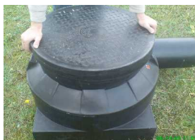
Zdj. nr 25. Montaż pokrywy Z600/DN 614-PE
