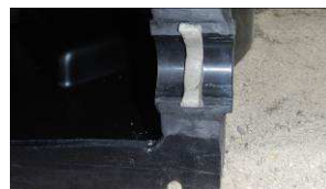
Zdj. nr 17, 18, 19. Zakładanie uszczelki UP w rowki i widok uszczelki w korpusie
