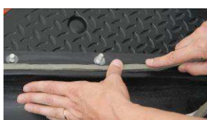
Zdj. nr 10, 11. Zakładanie uszczelki UP w rowki
