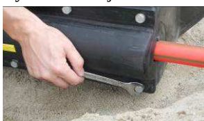
Zdj. nr 22, 23. Dokręcanie śrub w pokrywce bocznej
