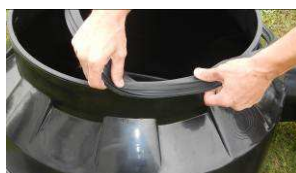
Zdj. nr 26. Zakładanie uszczelki gumowej
