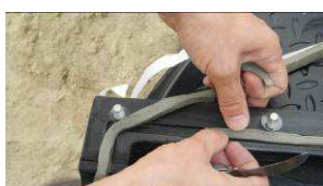
Zdj. nr 13, 14. Założenie uszczelki na zakładkę
