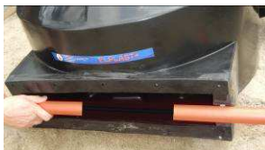
Zdj. nr 20. Umieszczenie rur w korpusie
