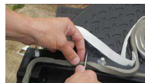
Zdj. nr 15. Odcięcie nadmiaru uszczelki
