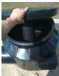
Zdj. nr 27. Zakładanie pokrywki Z600/DN 614-PE z rurą
