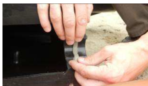
Zdj. nr 17, 18, 19. Zakładanie uszczelki UP w rowki i widok uszczelki w korpusie
