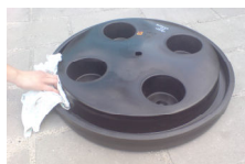
Zdjęcie nr 4. Czyszczenie miejsca połączenia
