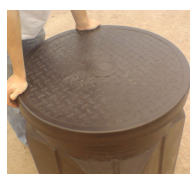
Zdjęcie nr 6. Montaż pokrywy Z600/DN 624-PE
