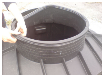
Zdjęcie nr 8. Montaż uszczelki DN 624
