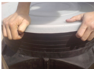
Zdjęcie nr 9. Montaż kaptura uszczelniającego DN 650-PE
