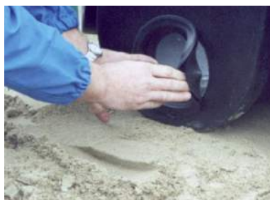
Zdj. nr 5. Zakładanie uszczelki wlotowej
