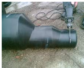
Zdj. nr 7 Przycinanie odpowiedniej średnicy na wylocie z kinety
