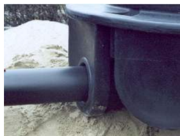
Zdj. nr 6. Montaż rury na wlocie
