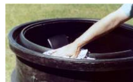
Zdj. nr 32 Czyszczenie „gniazda” pod uszczelkę UP
