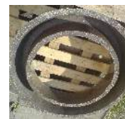
Zdj. nr 47 Widok z dołu
