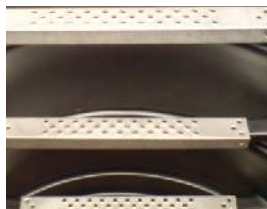
Zdj. nr 2. Stopnie złazowe ze stali nierdzewnej
