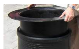
Zdj. nr 40 Montaż teleskopu
