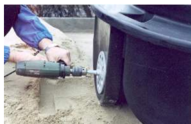
Zdj. nr 4. Wycinanie otworu wyrzynarką
