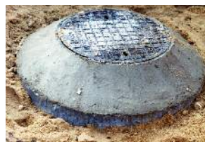
Zdj. nr 42 Zwieńczenie studzienki włazem żeliwnym
