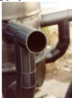
Zdj. nr 10) Przykład dwóch kaskad na studzience fi 1000 mm
