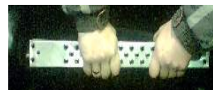
Zdj. nr 26 Zakładanie stopnia
