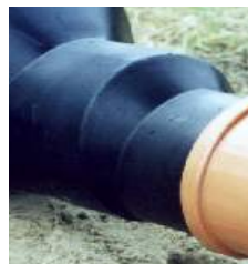
Zdj. nr 8 Montaż rury na wylocie
