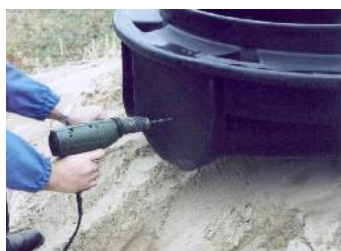
Zdj. nr 3. Wiercenie otworu pilotowego
