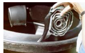
Zdj. nr 33 Zakładanie uszczelki UP
