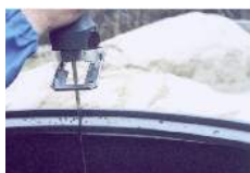
Zdj. nr 29 Nacinanie pierścienia usztywniającego
