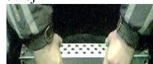
Zdj. nr 27 Zakładanie stopnia
