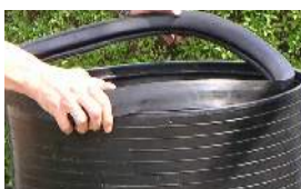
Zdj. nr 37 Zakładanie uszczelki
