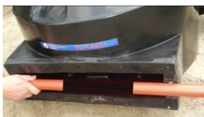
Zdj. nr 20. Umieszczenie rur w korpusie
