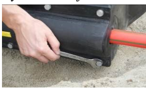
Zdj. nr 22, 23. Dokręcanie śrub w pokrywie bocznej
