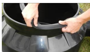
Zdj. nr 26. Zakładanie uszczelki gumowej
