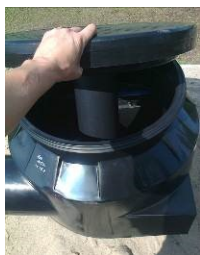
Zdj. nr 27. Zakładanie pokryw Z600/DN 614-PE z rurą
