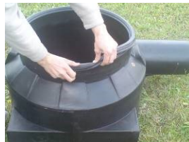
Zdj. nr 27. Montaż uszczelki DN 614
