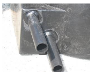
Zdjęcie nr 18. Dwie rury polietylenowe wstawiane do korpusu zasobnika
