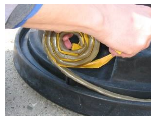
Zdjęcie nr 32. Nakładanie uszczelki UP
