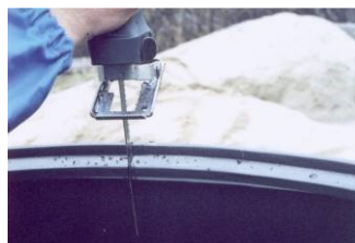
Rys. nr 9. Pierścień usztywniający Zdjęcie nr 21. Nacięcie pierścienia
