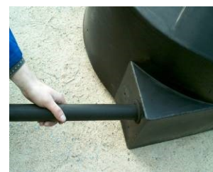
Zdjęcie nr 7. Zakładanie rury PE w gniazdo z uszczelką
