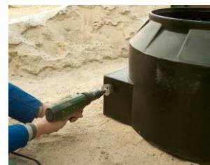
Zdjęcie nr 4. Wycinanie otworu wyrzynarką
