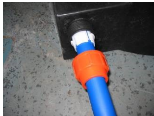
Zdjęcie nr 9. Montaż rury z korpusem zasobnika za pomocą złączki skręcanej
