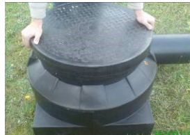
Zdj. nr 28. Montaż pokrywy Z600/DN 614-PE
