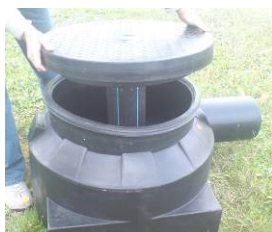
Zdjęcie nr 23. Zakładanie pokrywy
