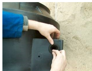
Zdjęcie nr 6. Zakładanie uszczelki wlotowej na wycięty otwór.
