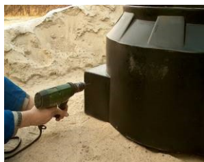
Zdjęcie nr 3. Wiercenie otworu prowadzącego
