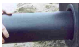
Zdj. nr 14. Montaż rury do korpusu z uszczelką
