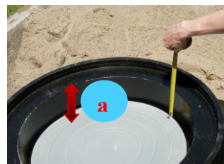
Zdj. nr 66 Dopasowanie wysokości pomiędzy kapturem, a pokrywą
