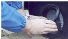
Zdj. nr 11. Zakładanie uszczelki wlotowej
