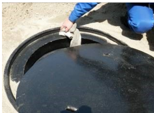
Zdj. nr 69 Czyszczenie z zabrudzeń
