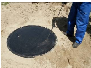
Zdj. nr 72 Zdejmowanie pokrywy PT-DN 680 za pomocą haka
