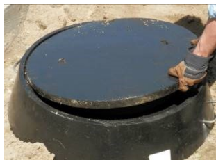
Zdj. nr 70 Zakładanie pokrywy na stożek
