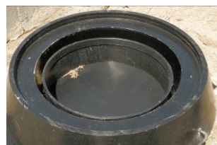
Zdj. nr 58 Założenie stożka na część cylindryczną
