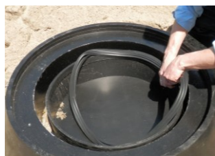
Zdj. nr 59 Założenie uszczelki
