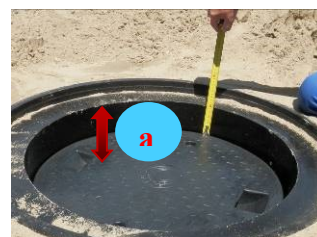
Zdj. nr 61 Dopasowanie wysokości pomiędzy pokrywami
