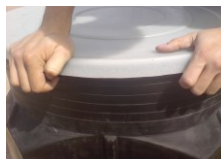
Zdj. nr 50. Montaż kaptura uszczelniającego DN 650-PE
