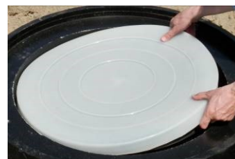
Zdj. nr 74 Zdejmowanie kaptura uszczelniającego
