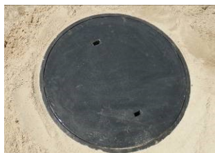
Zdj. nr 71 Zabudowane zwieńczenie tworzywowe
