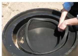
Zdj. nr 64 Założenie uszczelki
