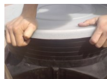
Zdj. nr 48. Montaż kaptura uszczelniającego DN 650-PE
