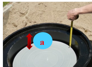
Zdj. nr 68 Dopasowanie wysokości pomiędzy kapturem, a pokrywą
