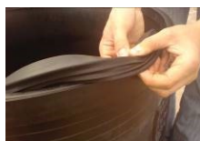
Zdj. nr 29,30,31. Montaż uszczelki DN 624
