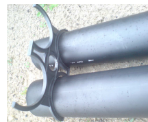
Zdjęcie nr 3 . Zabudowa przekładki w zestawie rur
